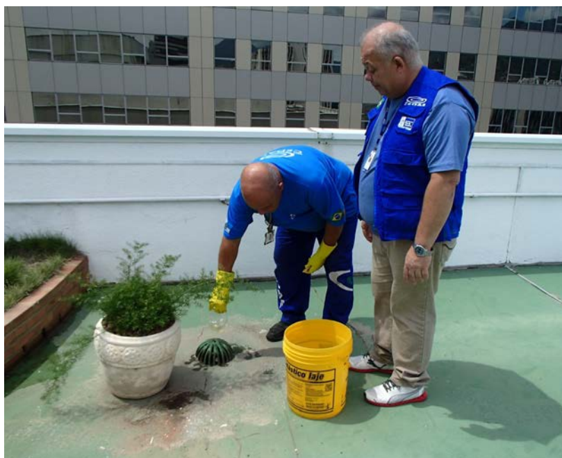
Figura 11: Aplicação de Hipoclorito de Sódio em unidade da CEDAE
