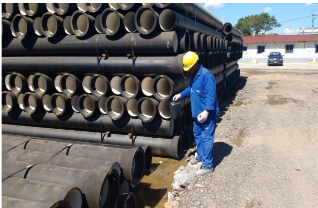
Figura 4: Aplicação de pó de pedra nas bolsas dos tubos para evitar acúmulo de água
